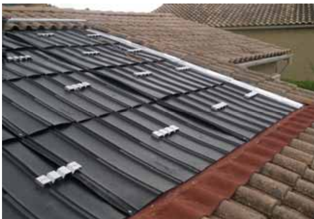
Deux exemples de « trou d'étanchéité » après démontage des tuiles, pour l'intégration des panneaux
