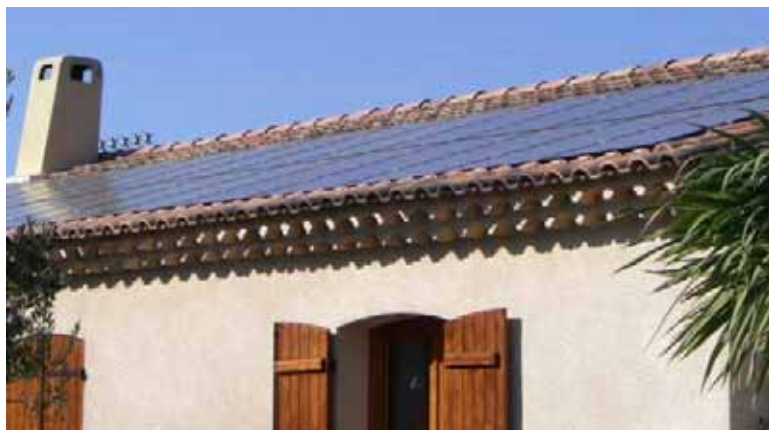
28 panneaux en intégration pour 6 kWC
