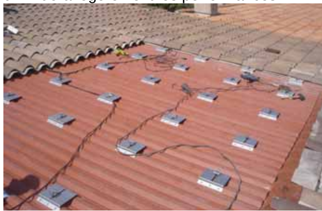
Deux exemples de « trou d'étanchéité » après démontage des tuiles, pour l'intégration des panneaux
