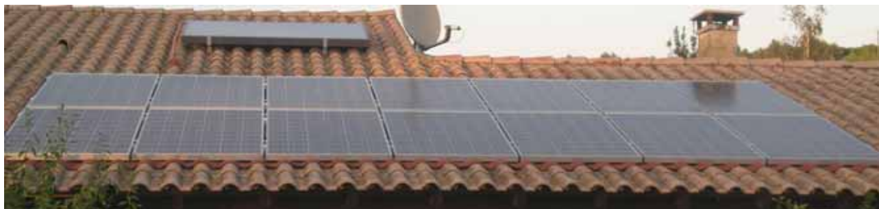
Installation mixte : 14 x PV en intégration (2940 WC) , 1 x CES en superposition
